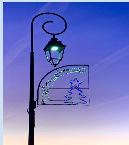
Remplacement de 4 lanternes
