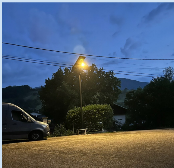
Mise en place d'un éclairage public
