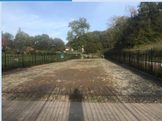
Engazonnement des espaces concédés et des allées du nouveau cimetière du Marillet
