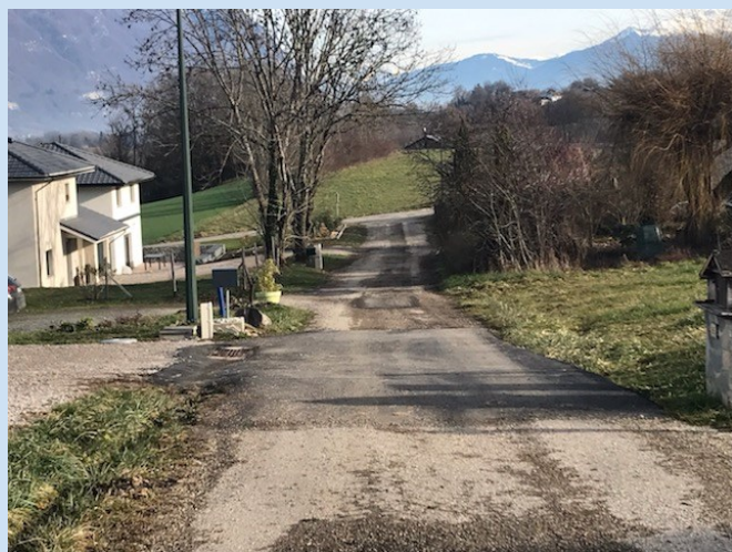
Travaux de voirie sur le chemin du Châtelet pour éviter les ruissellements d'eau.
